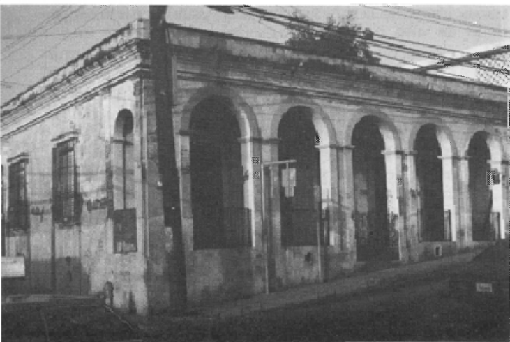
Ilustración 4 Estructura en mampostería en San Germán, calle Luna.
