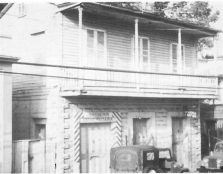
Ilustración 9 Estructura de uso mixto, con residencia en la planta alta y área comercial en la planta baja, calle Luna; primer piso en mampostería, segundo piso en madera.
