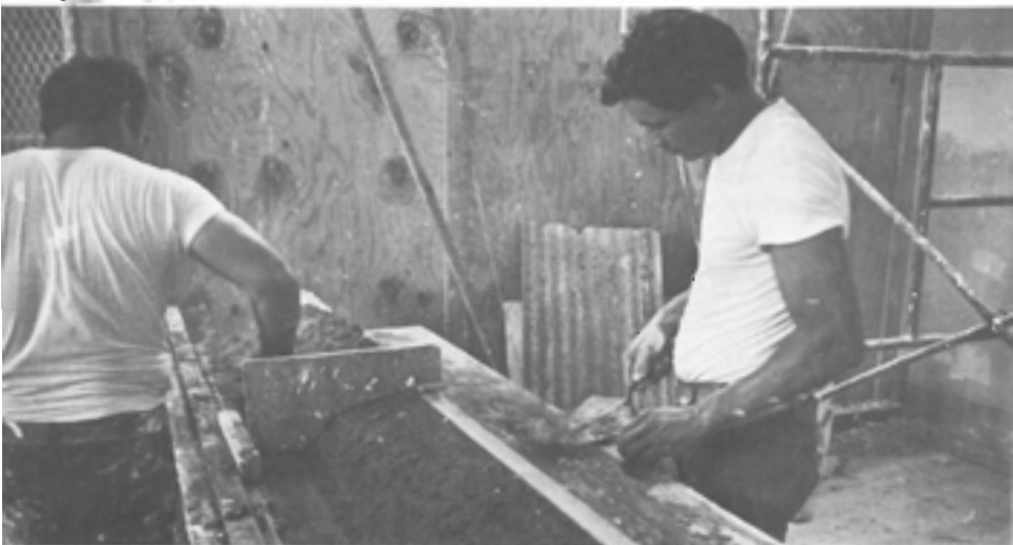
Alberto Burgos Flores y su ayudante ya han preparado la base de arena mojada y compactada y están pasando la plantilla para definir los perfiles de la cornisa.
