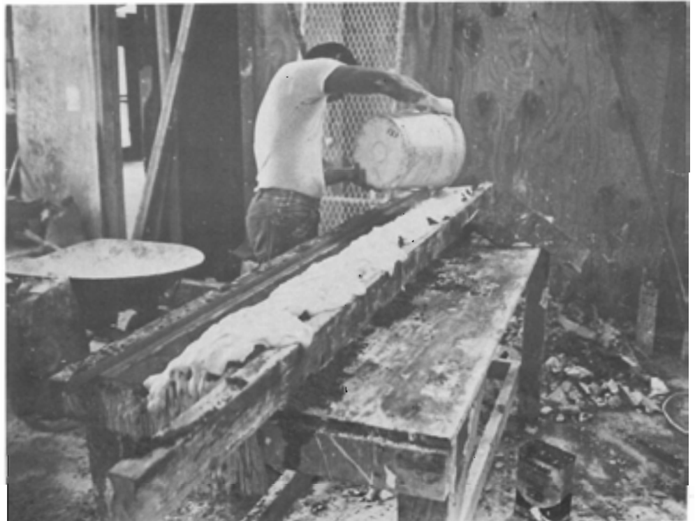
Se echa el yeso líquido sobre la arena compactada.
