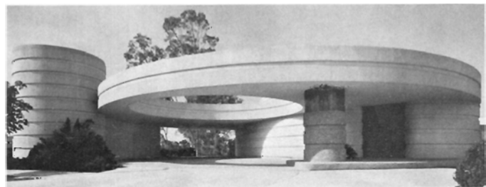
Casa Habitación, Mexico. Arquitecto: Agustín Hernández
