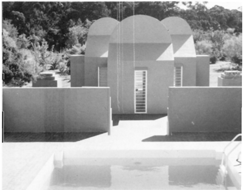
"Como la zona es muy calurosa en verano y la casa es si muy chica, le dije a Edgardo que proyectara una pileta, que resultó ser por su tamaño, en particular por su profundidad, un monumento a la natación" . Casa Romero Brest, Punta Indio.
