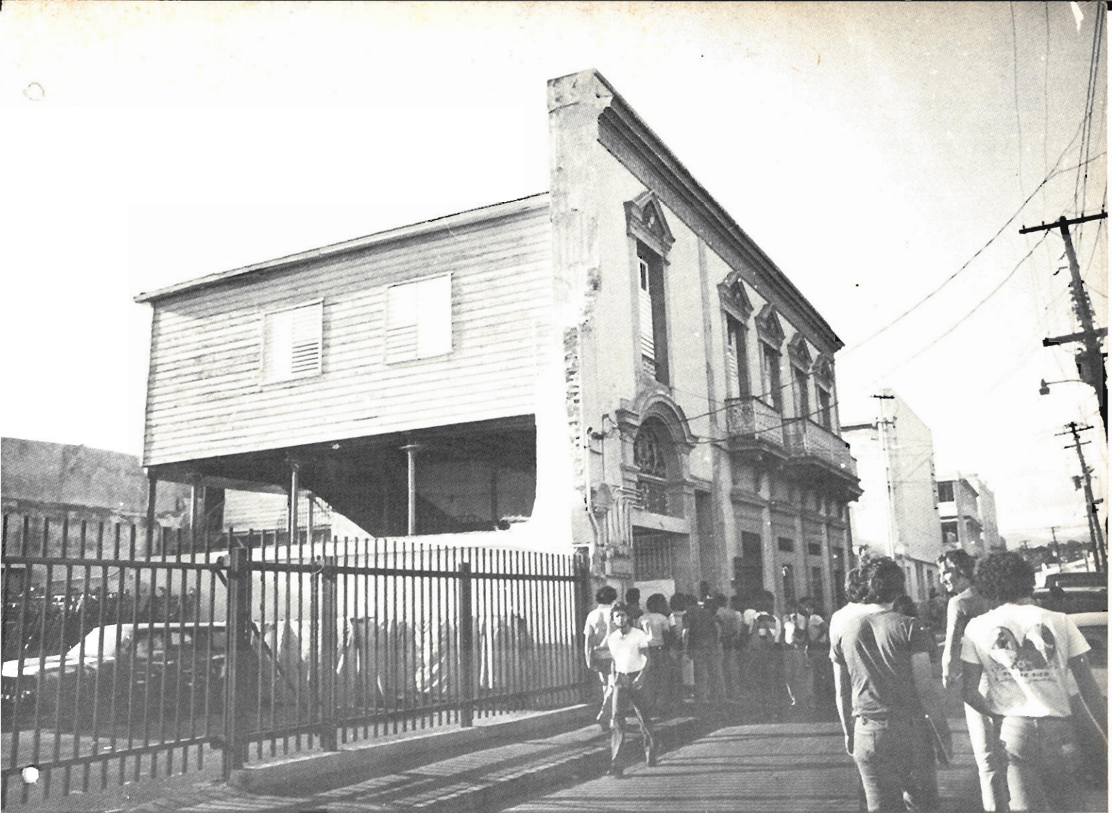
Ejemplo de un edificio pintura en Ponce. Al demolerse la estructura que estaba a su lado, queda expuesto el cuerpo del edificio, totalmente diferente a su fachada. Esta fachada es plana, poco profunda y se experimenta como una pared continua. (Foto: Víctor Zamparelli).
